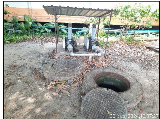
ภาพที่ 9 ถังเกรอะ-กรองไร้อากาศ
